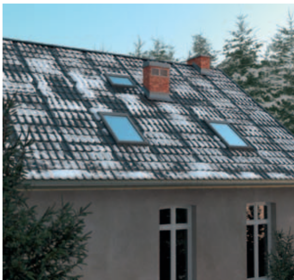
1.3. Przykład występowania mostków cieplnych – stopiony śnieg w miejscach przenikania ciepła przez krokwie na dachu
